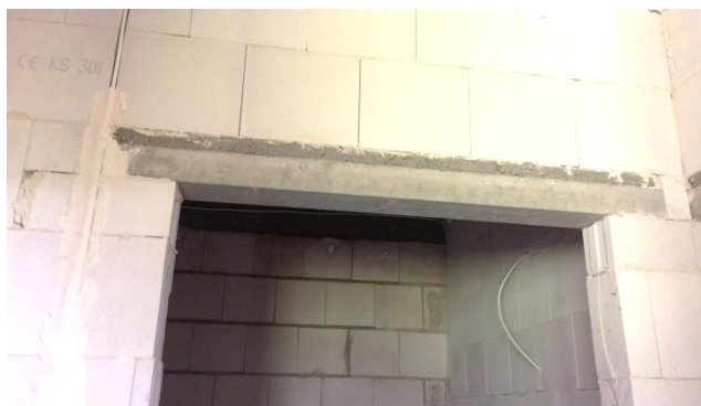
1 nosný preklad na deliacej priečke 115 mm
