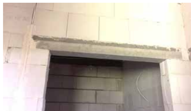
1 nosný preklad na deliacej priečke 115 mm
