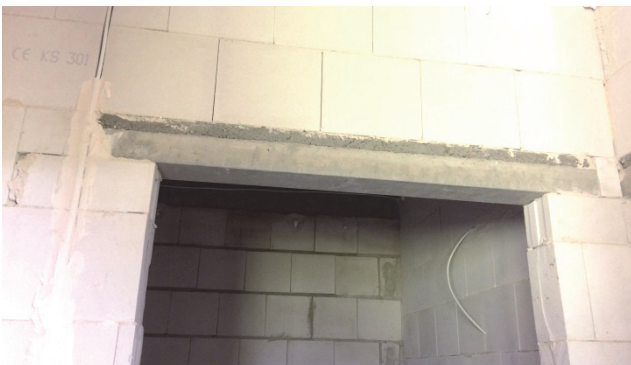
1 nosný preklad na deliacej priečke 115 mm
