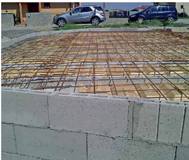
Obr. 9 Strop bez montážnych podpier na odvetranom priestore, rodinný dom vo Vrábľoch
