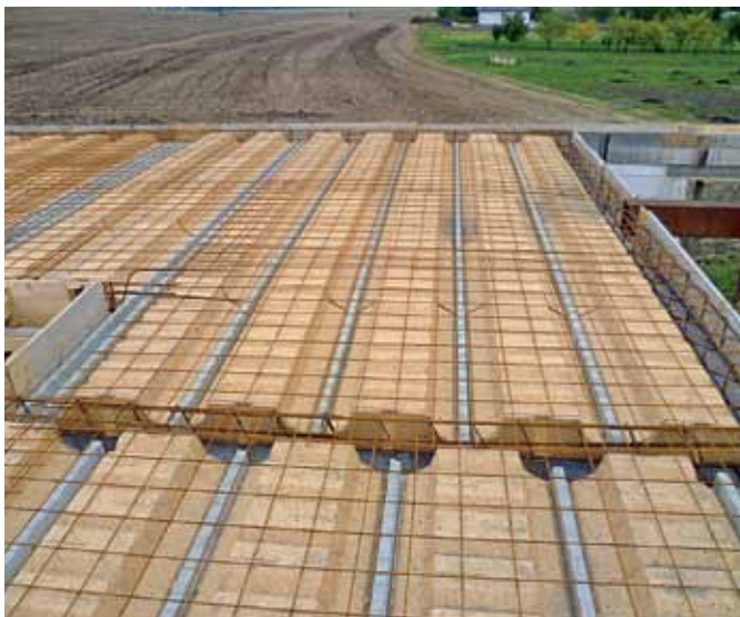
Obr. 8 Ocelové prúty výstuže sa ukladajú po jednom kuse (v niektorých prípadoch aj po dvoch kusoch) nad koncom každého nosníka a priviažu sa drôtom z vrchnej strany k armovacej sieťovine s presahom od 1 cm do 6 cm
