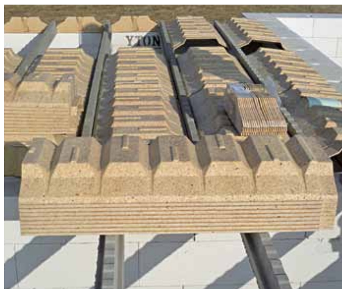
Obr. 6 Ukladanie stropných vložiek na predpäté nosníky, rodinný dom v Dražkovciach
