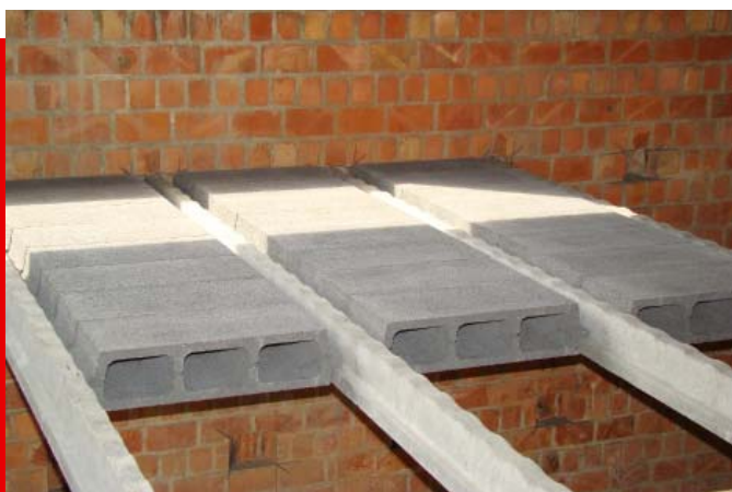
> Výmena stropu na strop RECTOBETON
