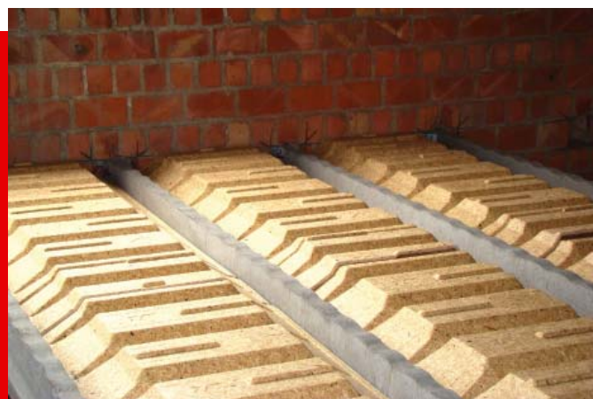
> Výmena stropu na strop RECTOLIGHT
